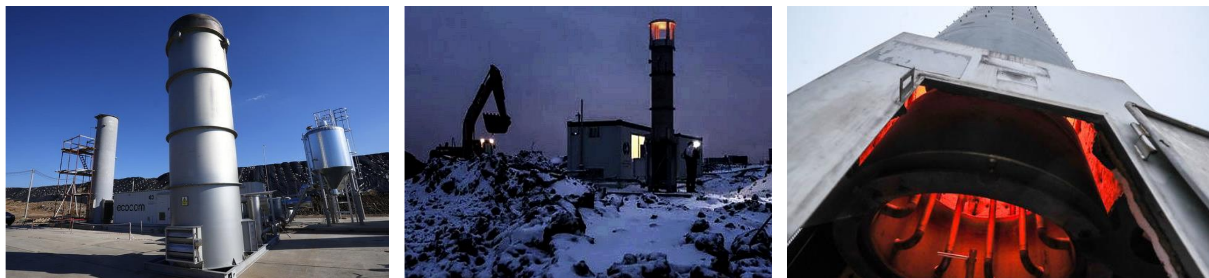
Рис. 12. Полигон ТБО «Кучино» в Балашихе: слева — общий вид с двумя высокотемпературными факелами (сентябрь 2018); в центре и справа — сжигание свалочного газа в открытых факелах (декабрь 2018). Фото с сайтов https://riamobalashiha.ru/article/200068/vtoroj-vysokotemperaturnyj-fakel-ustanovili-na-poligone-tbo-kuchino.xl , https://news.rambler.ru/other/38837823-predsedatel-mosobldumy-zayavil-o-zhestkom-kontrolе-rabot-po-degazatsii-kuchino/ и
